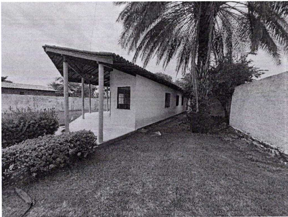
Foto 20 – Jardim/ Fachada Lateral
