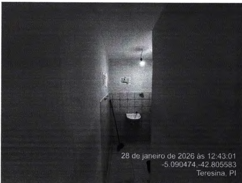
Figura 9: Vista entrada banheiro
