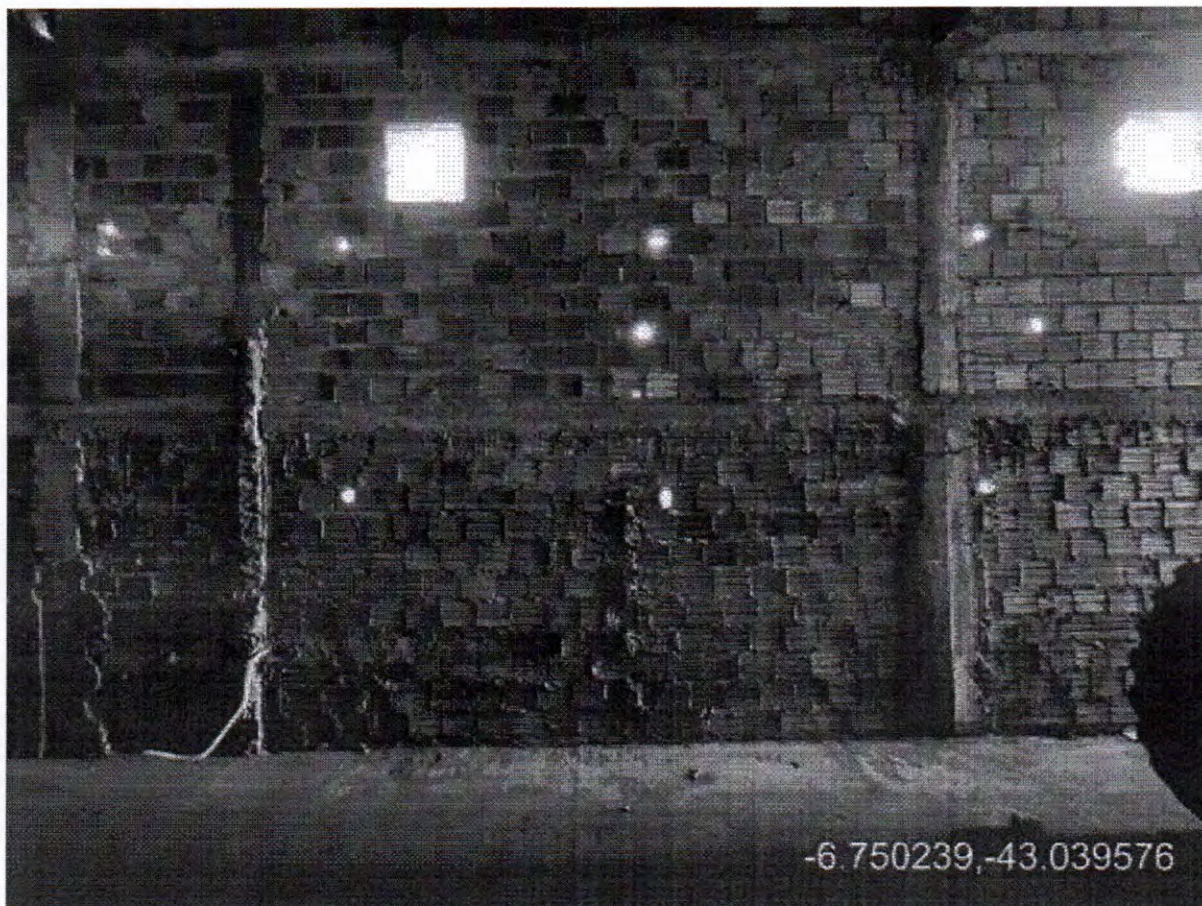
Figura 4: Vista de uma das paredes e Estrutura de local
