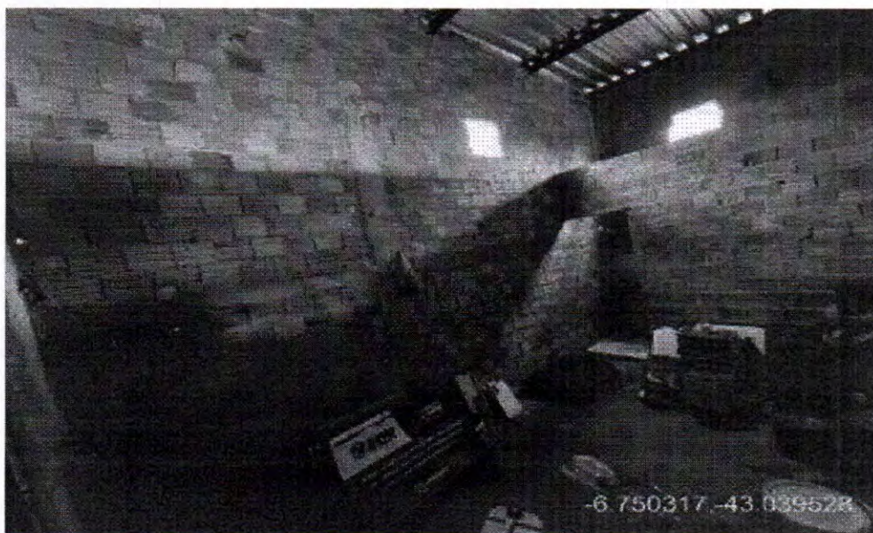
Figura 6: Vista do depósito do galpão
