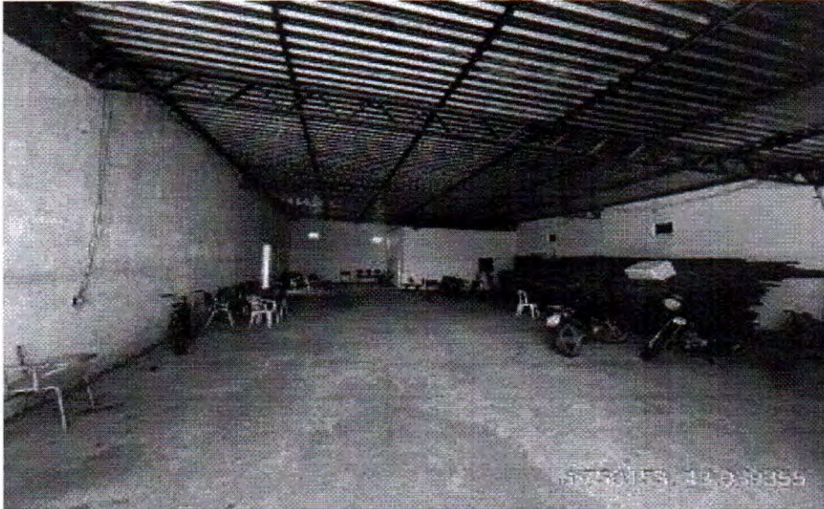
Figura 8: Vista interna, telhado aparente
