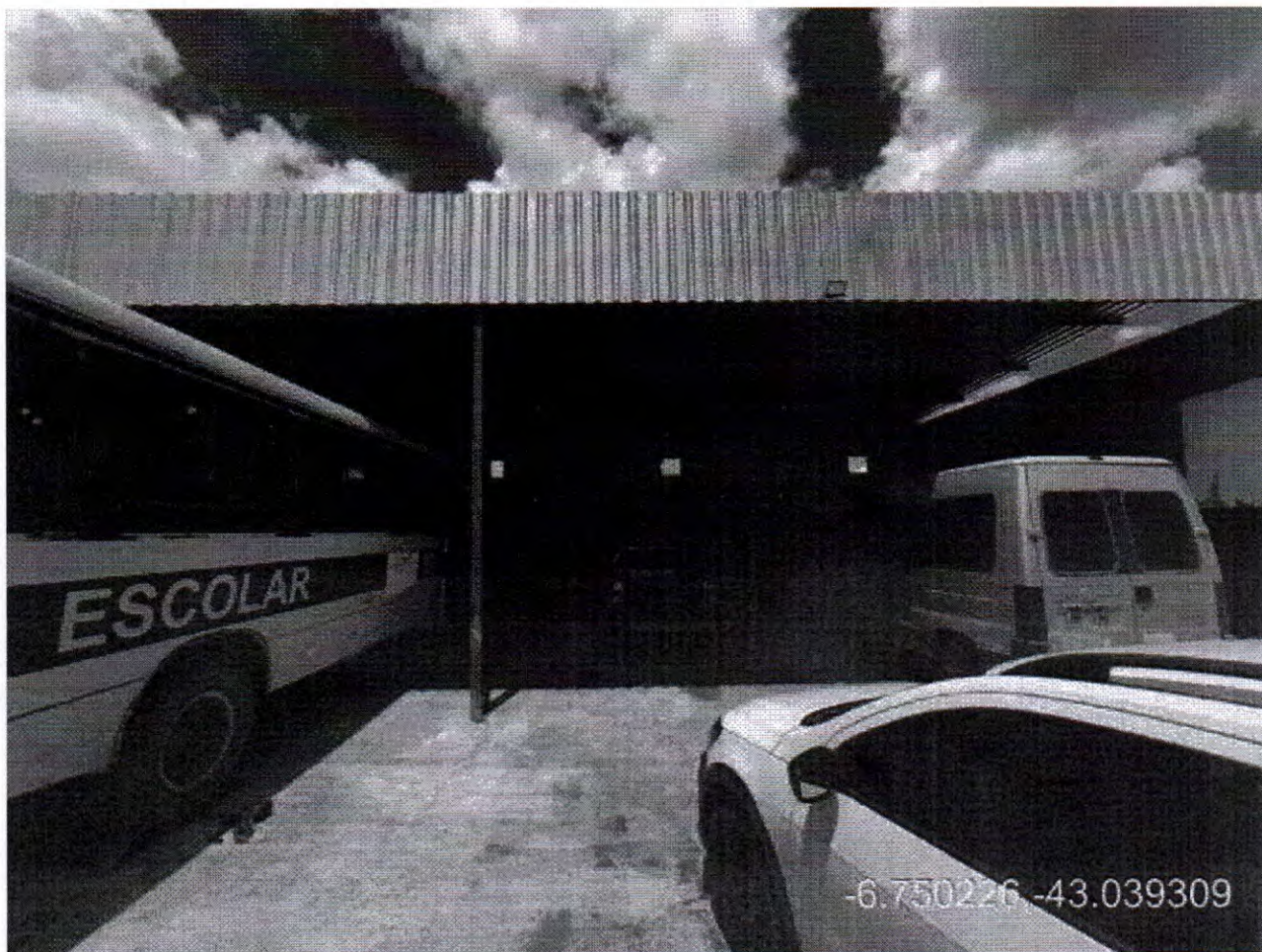
Figura 12: Vista da estrutura do telhado e vista geral do local
