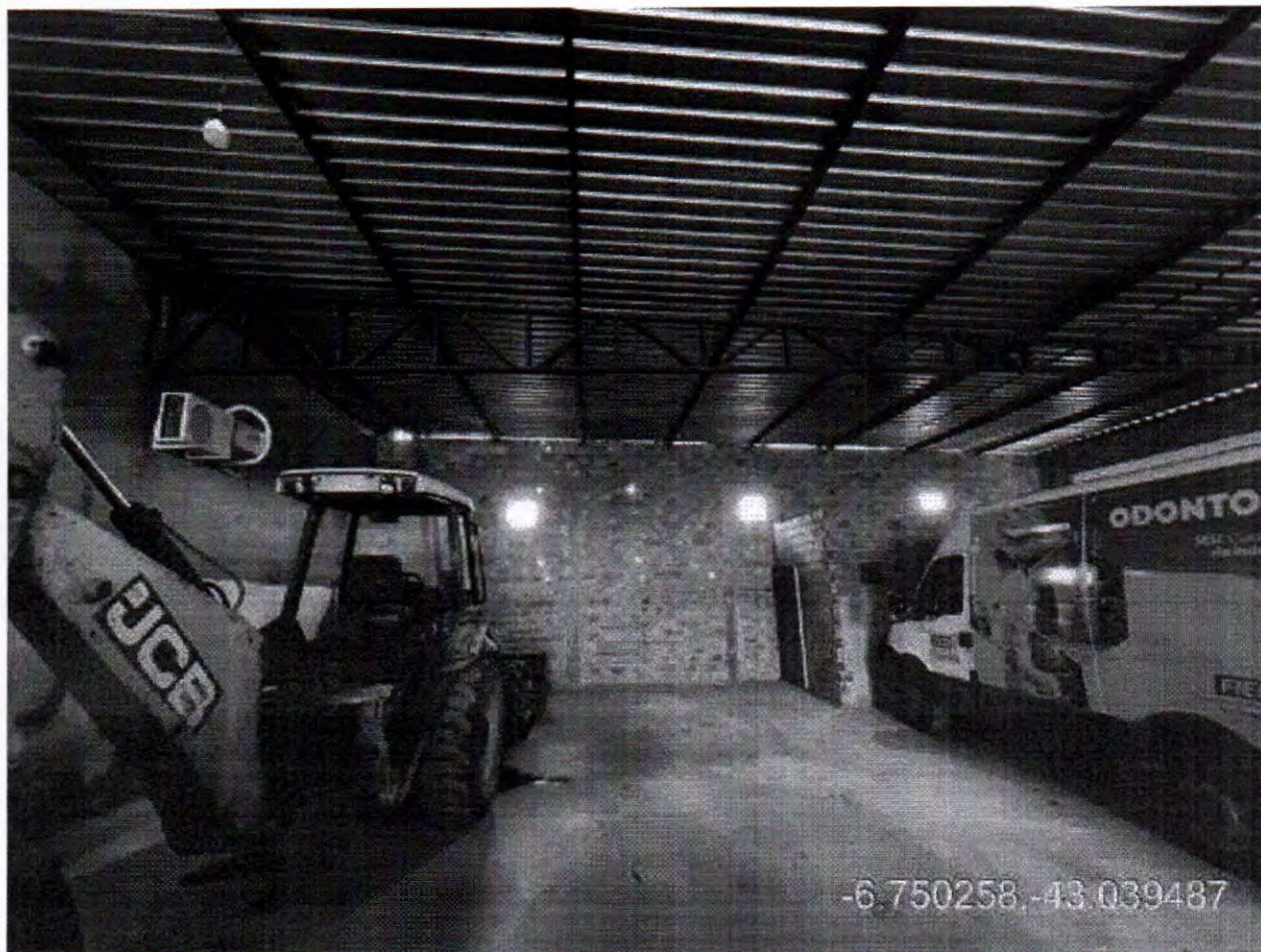
Figura 3: Vista Interna, telhado, estrutura.
